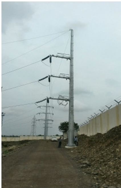
132 kV S/C, MSETCL
